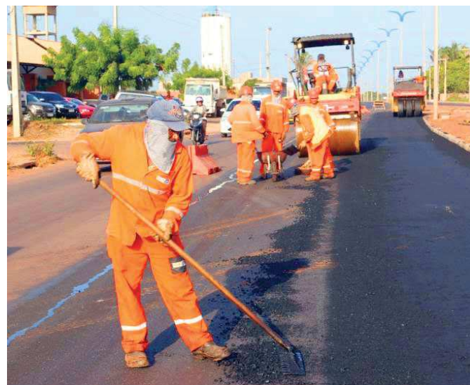
Pavimentação está sendo feita e MA-203 terá seis pistas
