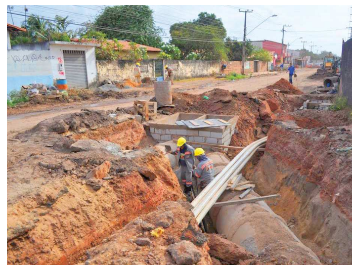
Forquilha está recebendo tubulações nas obras de drenagem
