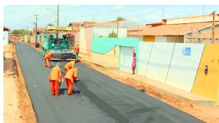
Serviço de pavimentação concluído em rua da área da Forquilha
