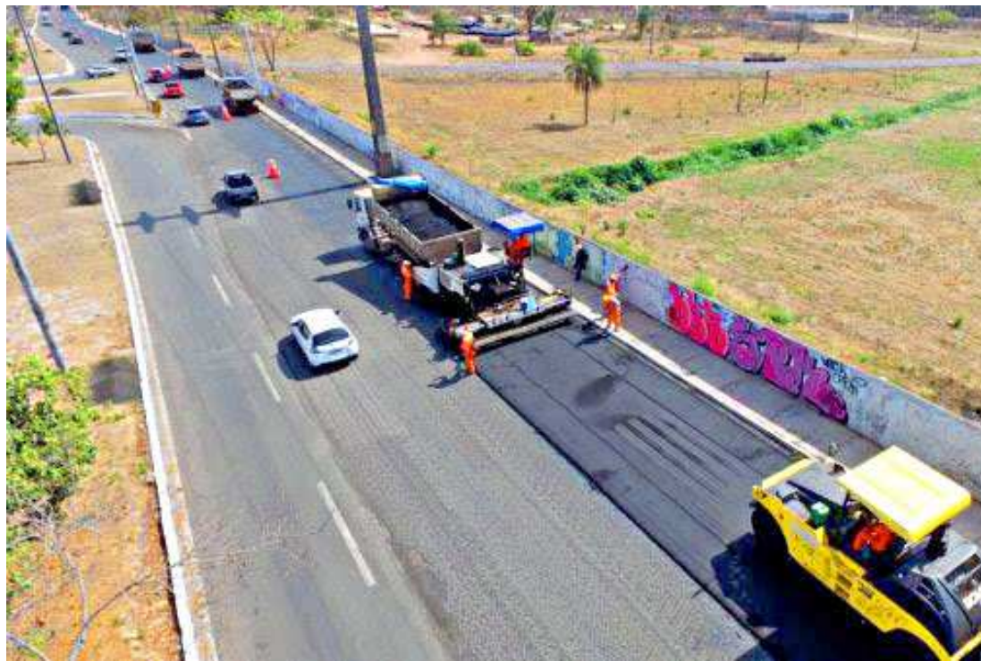
Máquinas estão resalizando a pavimentação ao longo da avenida, que terá mais mobilidade após os serviços
