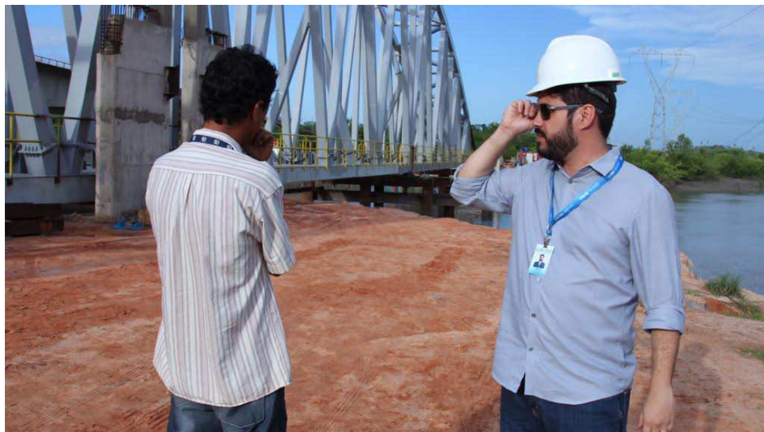
Presidente da Caema, Davi Telles, acompanhou de perto os trabalhos de operação da nova estrutura metálica
