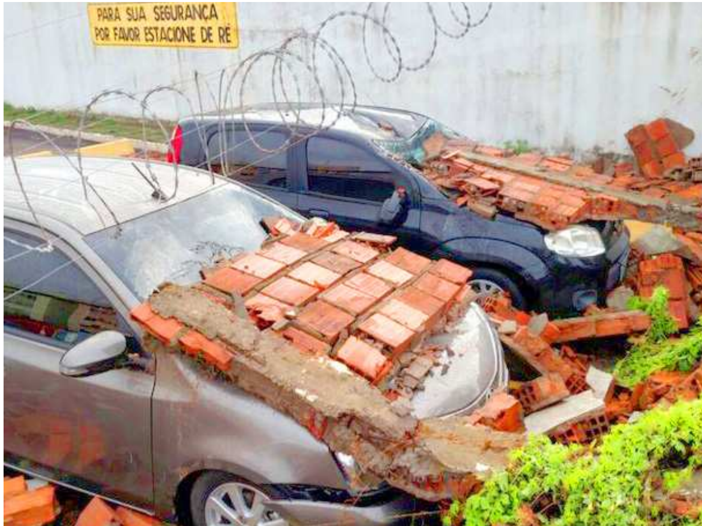
O muro de um condomínio, no bairro da Cohama, caiu, por conta da chuva, em cima de mais de dez veículos, causando prejuízo aos moradores
