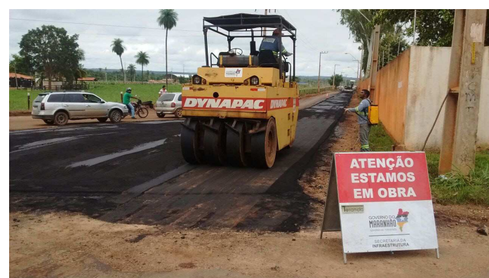
Via de acesso aos residenciais Sebastião Regis e Canto da Serra
