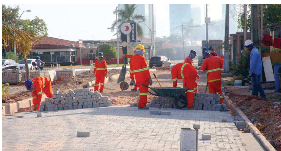
O programa ‘Mutirão Rua Digna’ visa a pavimentação de vias em sistema de cooperação com as comunidades
