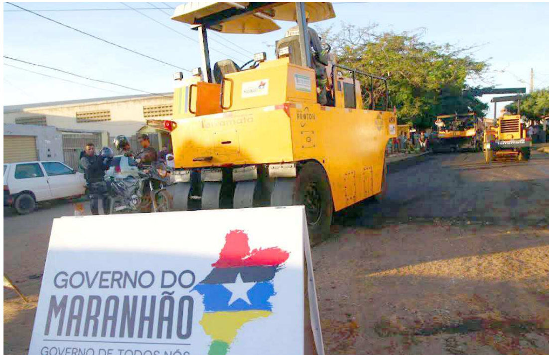
Doas obras serão entregues agora no mês de fevereiro em Itaipava do Grajaú e Coelho Neto
