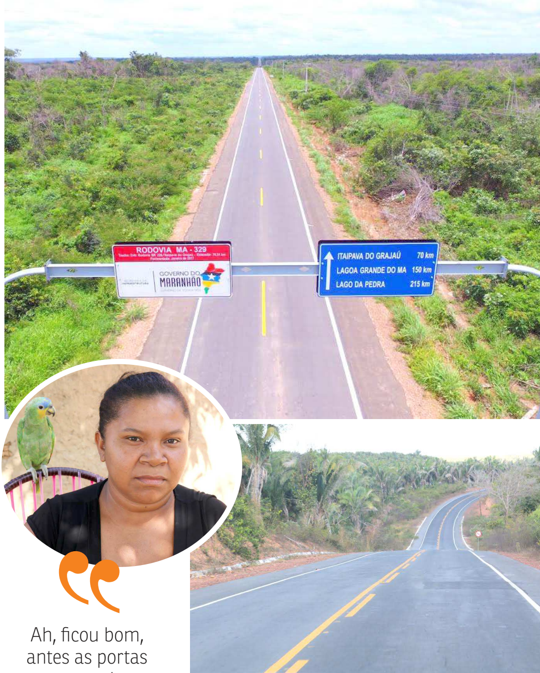
MA-329 antes e depois das obras realizadas pela Sinfra
