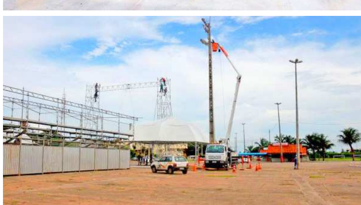
Homens estão trabalhando os últimos detalhes da Passarela do Samba
