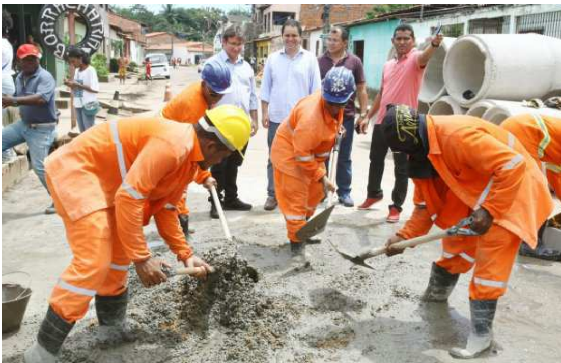
Prefeito Edivaldo Holanda Júnior vistoria obras de drenagem que estão sendo feitas no bairro Coroado
