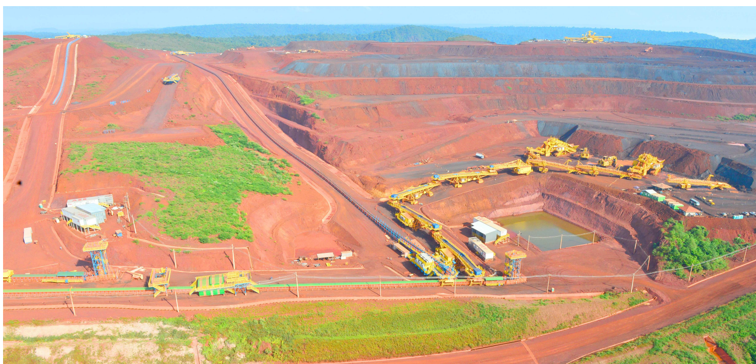
A mina e a usina estão localizadas em Canaã dos Carajás, no Pará, mas as obras vêm sendo executadas simultaneamente nos dois estados
