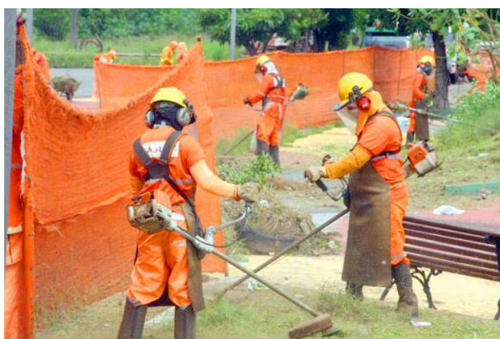
Estão sendo feitas capina, pintura de meio-fio e recuperação asfáltica
