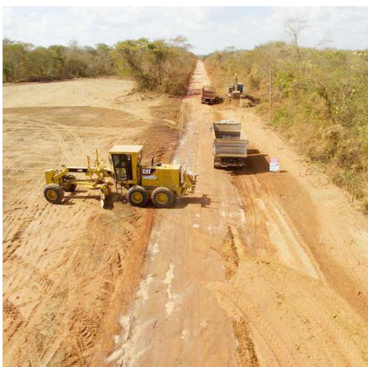
Atualmente, os trabalhos na MA-012 estão na fase de terraplanagem
