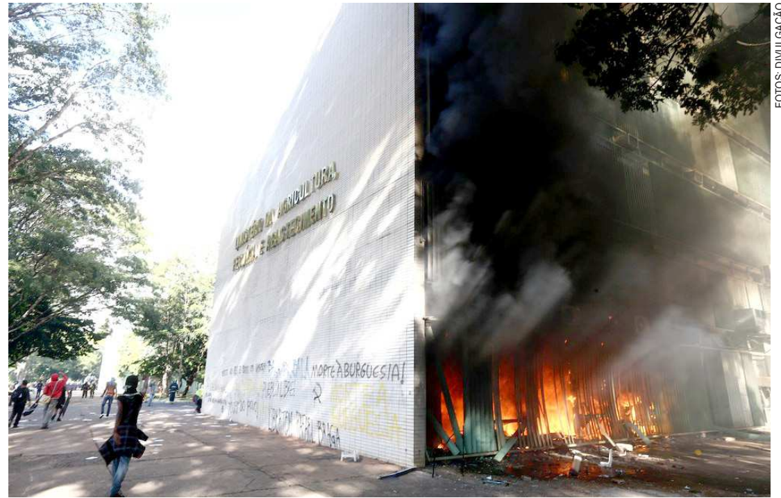
O primeiro prédio a ser atingido pelo fogo foi o do Ministério da Agricultura, apagado cerca de 40 minutos depois
