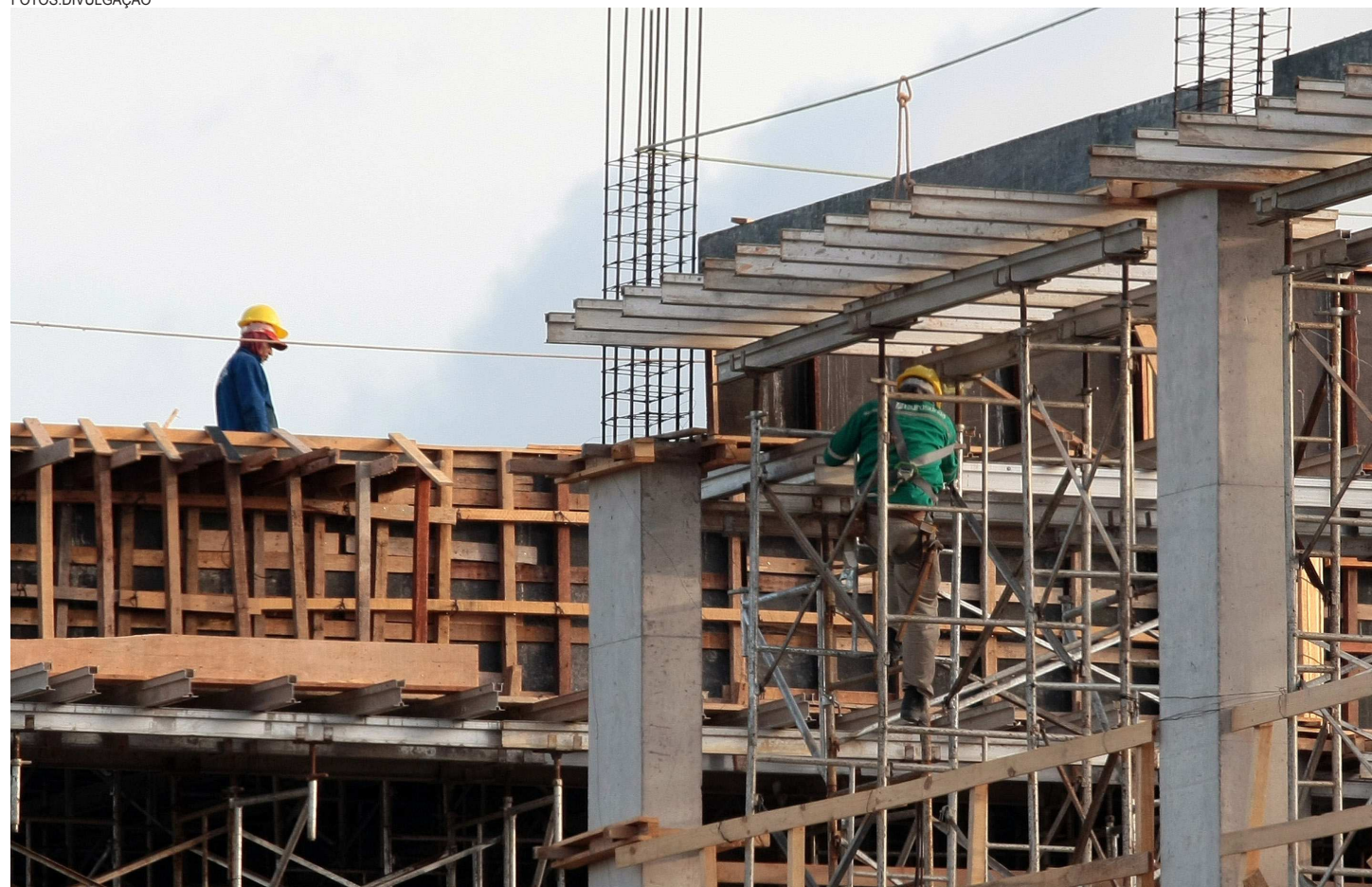
Em abril, o setor da construção civil do Maranhão teve um considerável aumento de 6 pontos no nível da atividade em relação ao mês anterior
