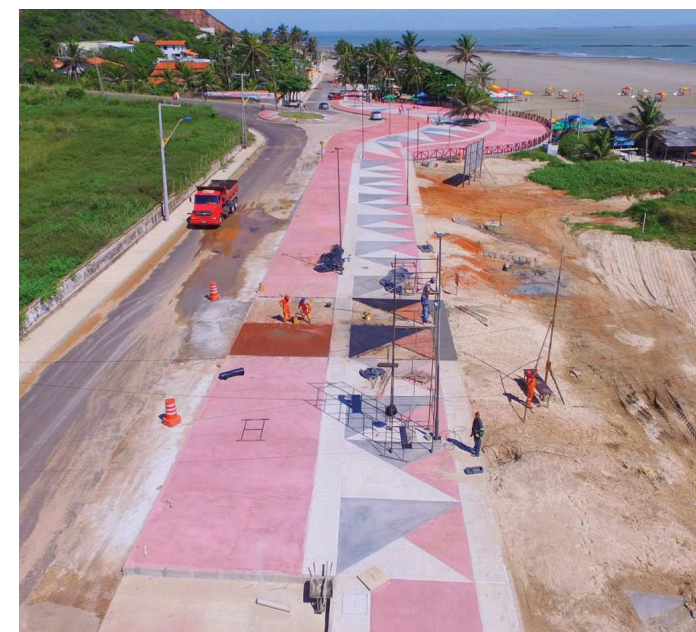
Obra foi realizada pela Sinfra, em parceria com a Prefeitura de Ribamar
