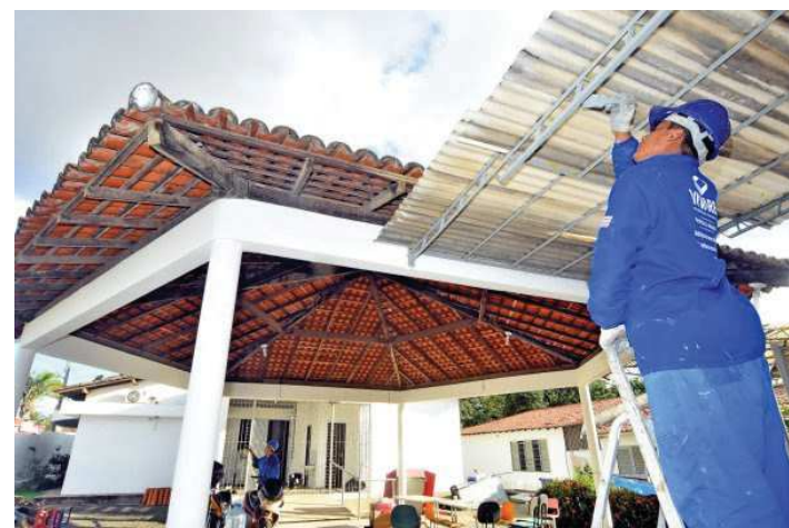
Em duas unidades, as obras serão concluídas no segundo semestre
