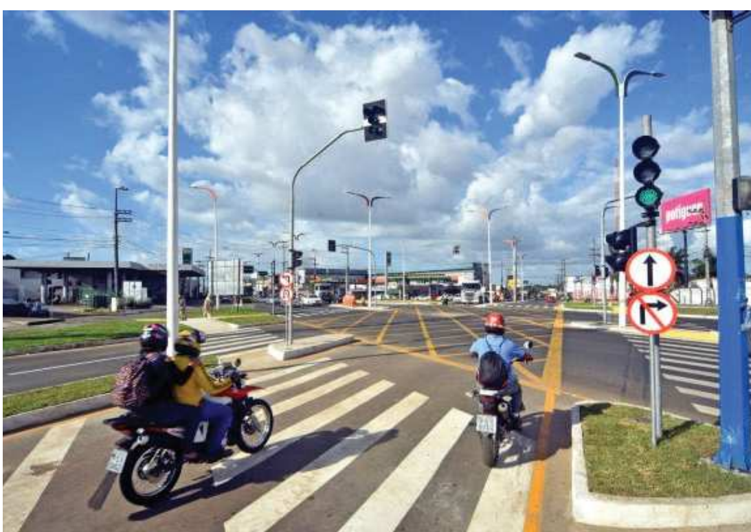
Além das obras na Forquilha, outras intervenções foram executadas para desafogar o trânsito naquela região
