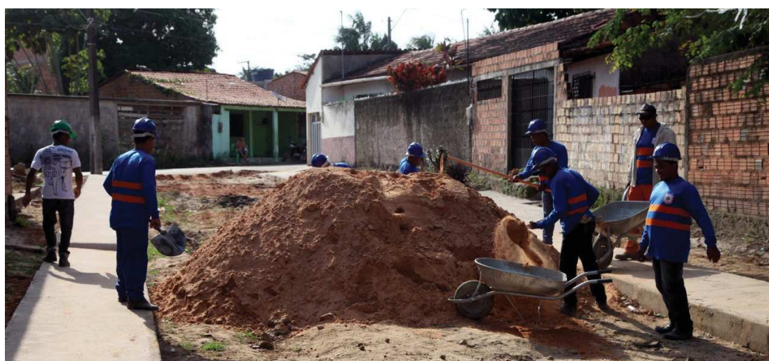
O programa vai realizar a pavimentação de vias públicas que nunca receberam qualquer tipo de intervenção
