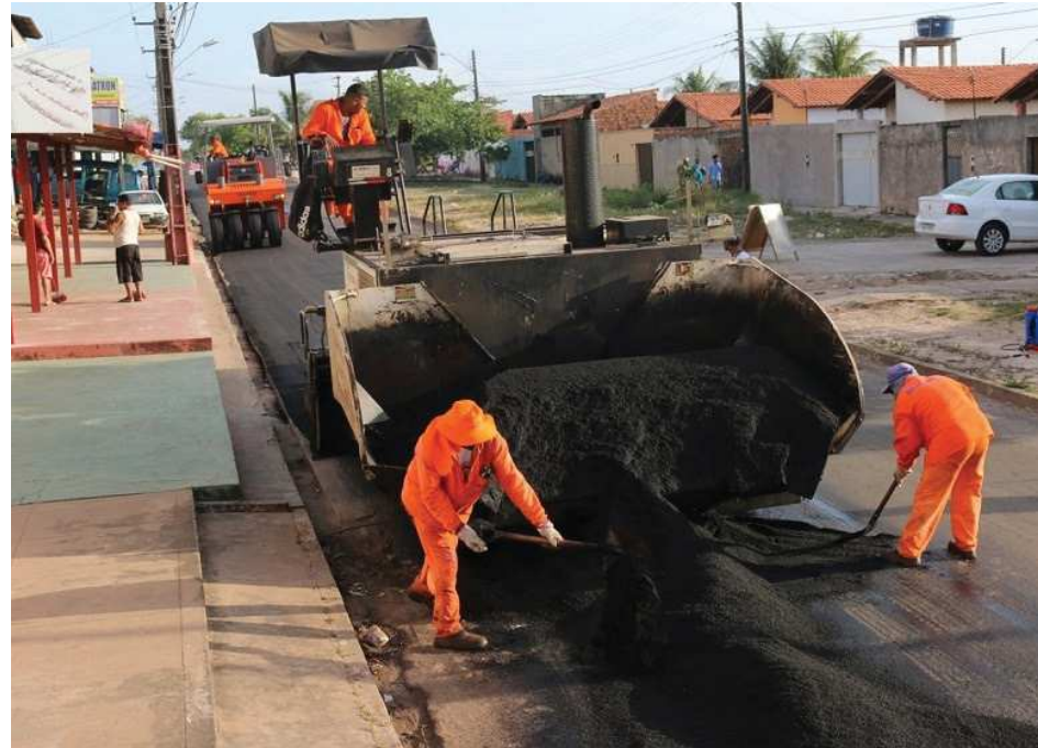
Obras do Mais Asfalto na Cidade Operária recuperou diversas ruas e avenidas do bairro
