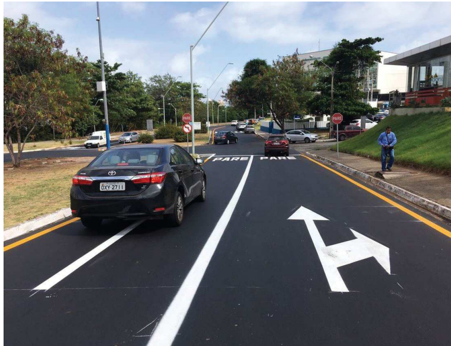
Avenida Professor Mário Meireles, na Lagoa da Jansen, após as obras do programa
