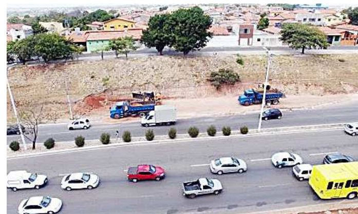
Avenida será alargada nos dois sentidos e criados dois retornos
