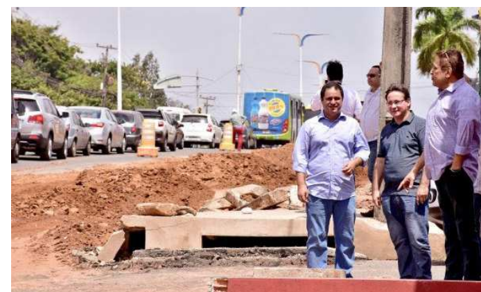
Edivaldo vistoriando uma importante obra de intervenção viária
