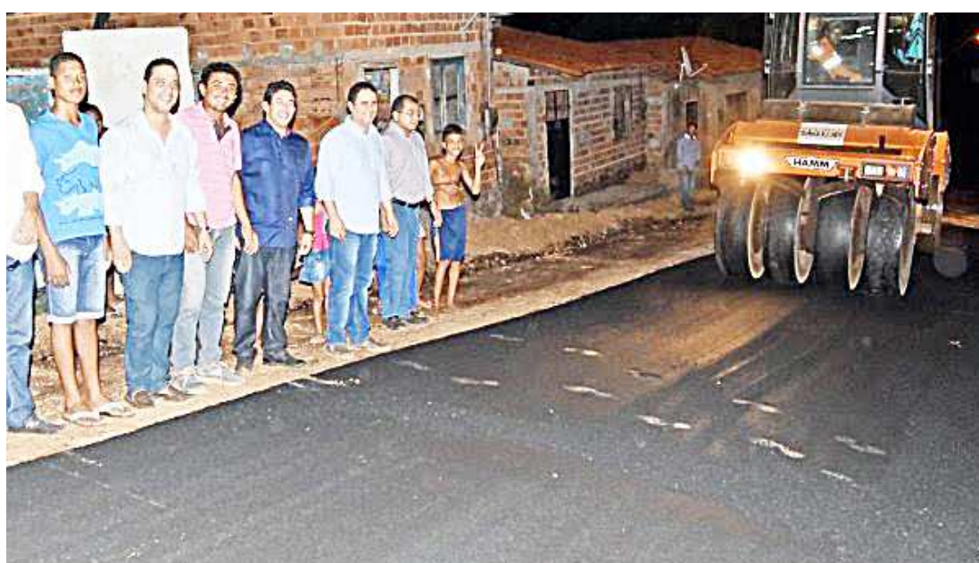
A pavimentação asfáltica valorizou aproximadamente três mil residências no Residencial Paraíso
