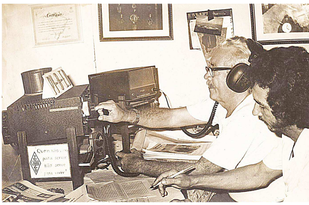
Estação Transmissora PRJ-9 – Rádio Difusora entrou no ar, oficialmente, no dia 15 de agosto de 1940
