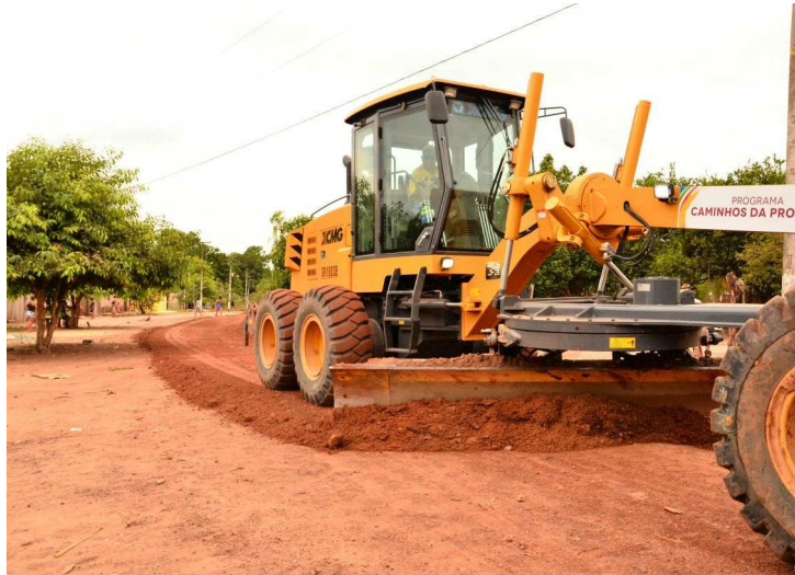
As máquinas também facilitarão os serviços de abertura de estradas
