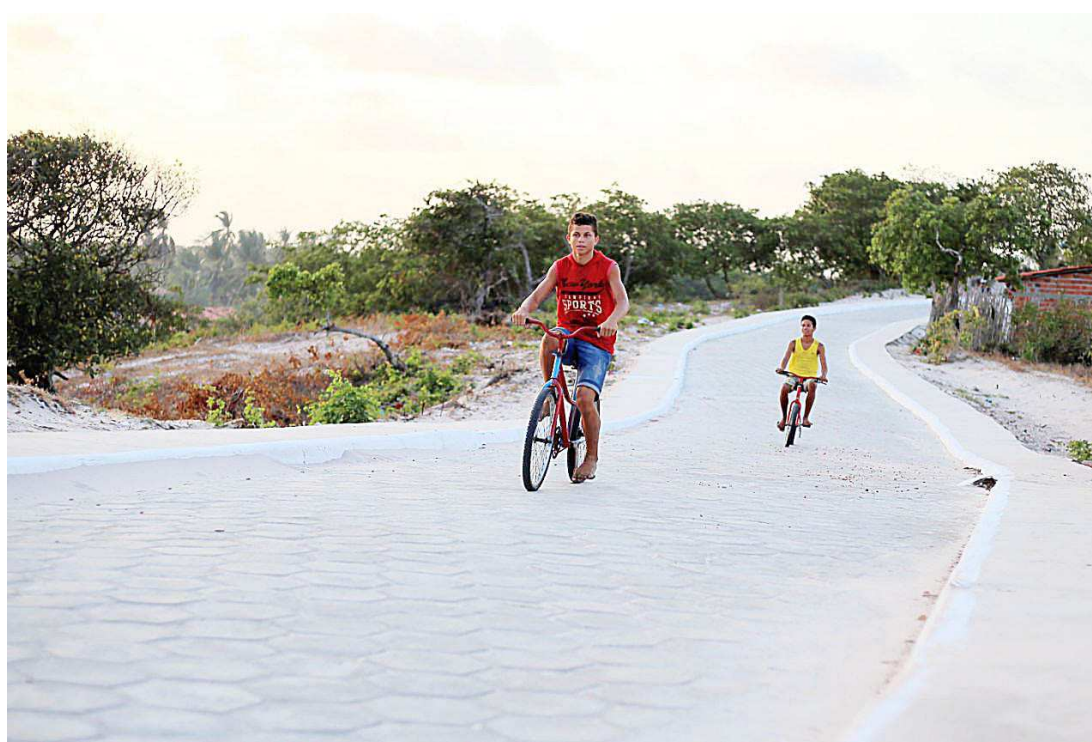
Localizada a 100 quilômetros de São Luís, a cidade de Primeira Cruz foi a primeira do estado a concluir a obra
