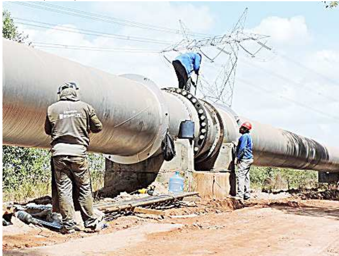
Equipes se revezam para finalizar obra de instalação da adutora e regularizar abastecimento de água
