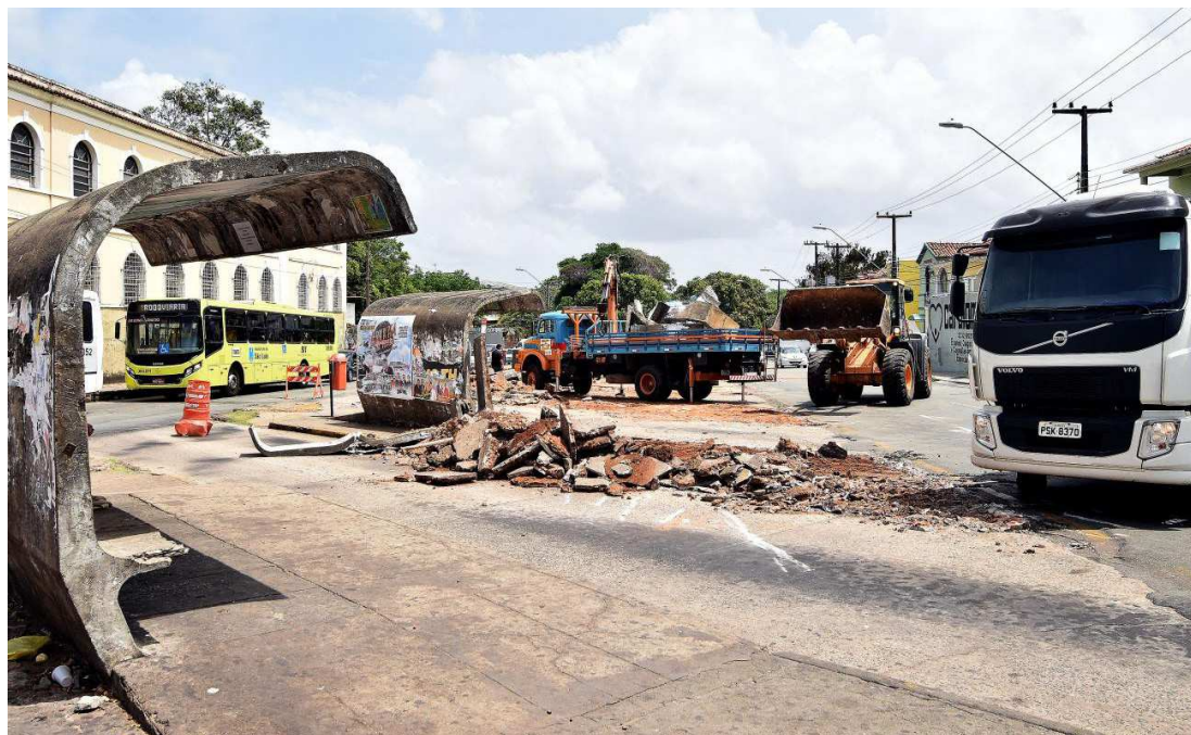
O projeto de requalificação urbanística do Complexo Deodoro vai promover a reestruturação total da área
