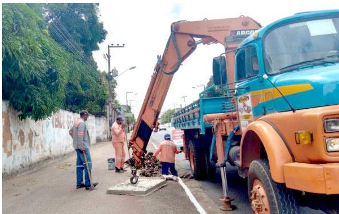
Durante a desobstrução das galerias, a prefeitura remove os resíduos acumulados de descarte irregular
