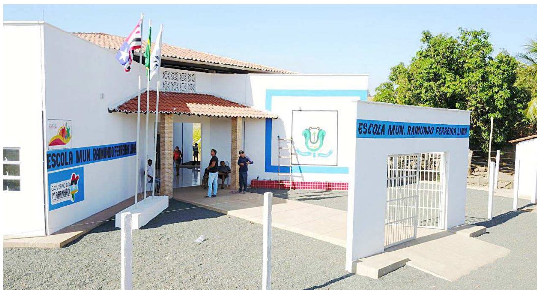
Em toda a parte sul do estado, escolas dignas estão sendo construídas, já foram 12; além da reforma e reconstrução
