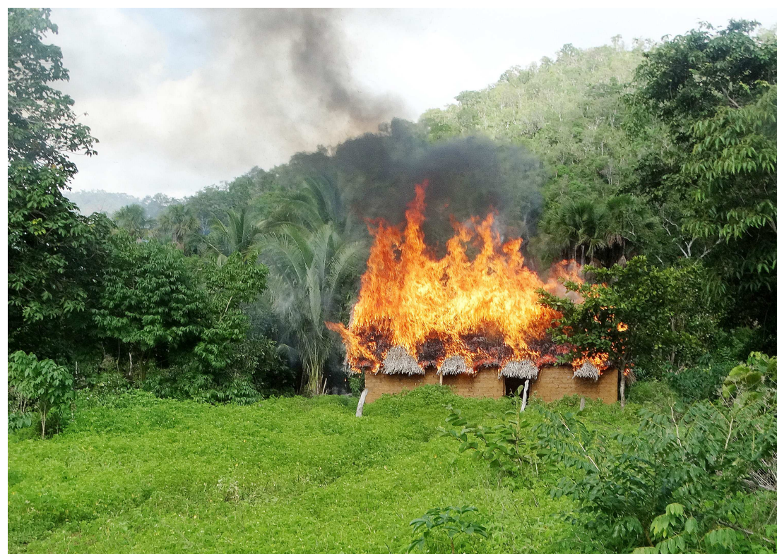
Durante a ação houve derrubadas e queimadas de casas abandonadas por invasores da área de conservação
