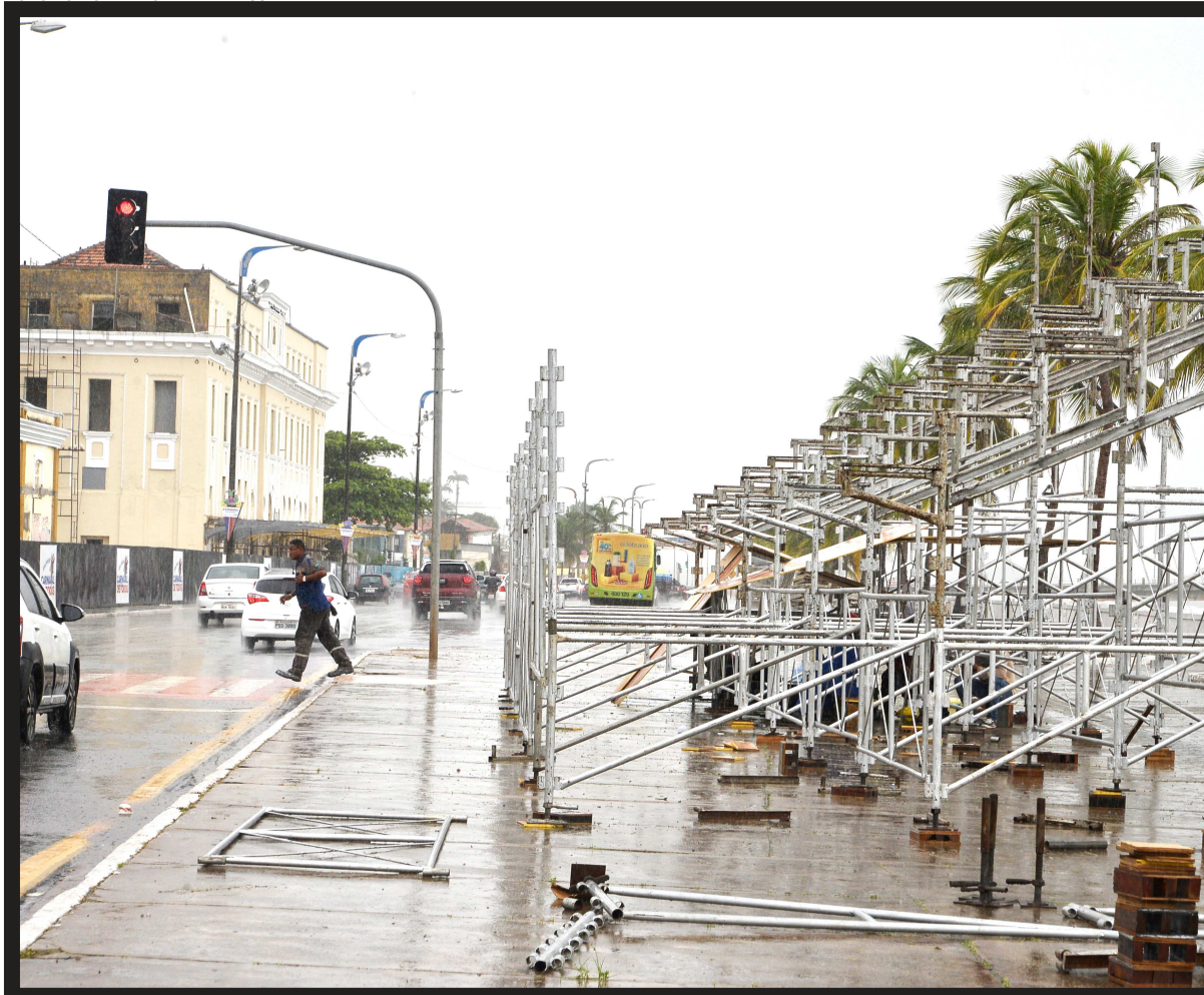
Estrutura para o Circuito Beira-Mar vai reunir dezenas de blocos por dia, revitalizando a área
